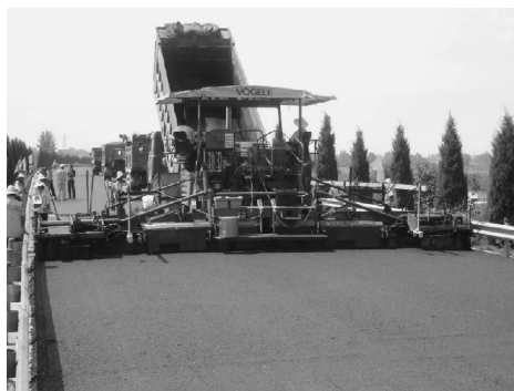
图 2-26 摊铺沥青路面
