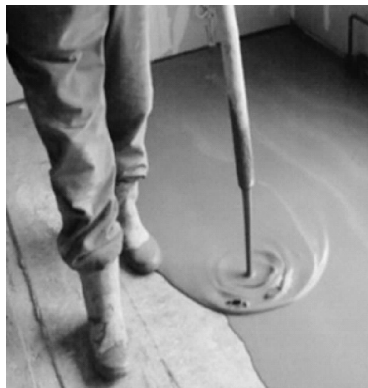
图 2-36 自流平砂浆施工
