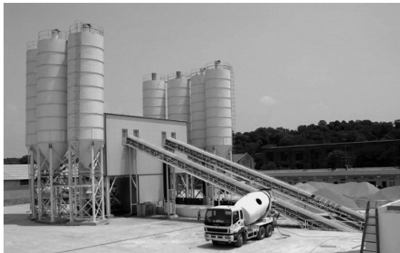
图 2-27 商品混凝土搅拌站及搅拌车
