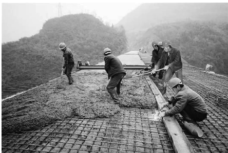
图 2-29 铺设钢筋混凝土
