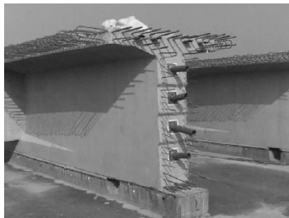
图 2-30 预应力混凝土简支梁
