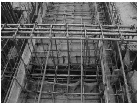
图 2-45 钢筋混凝土中的钢筋
