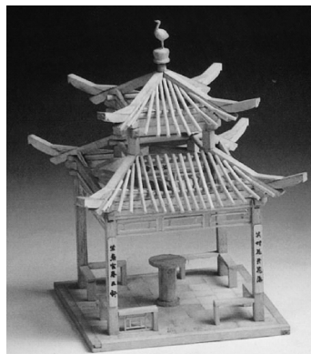
图 2-3 重檐方亭的木构架模型
