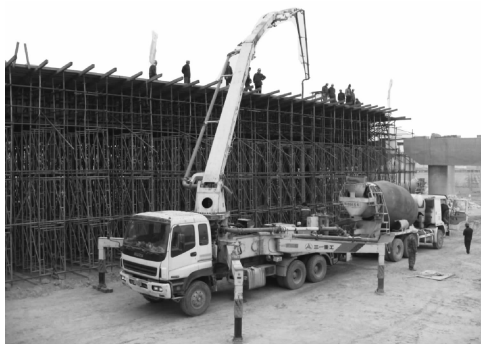
图 2-31 泵送混凝土施工
