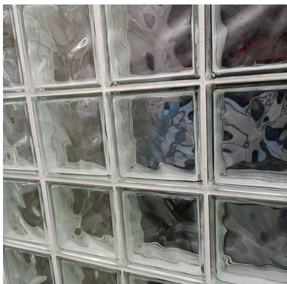
图 1-37 玻璃块材屏风隔断
