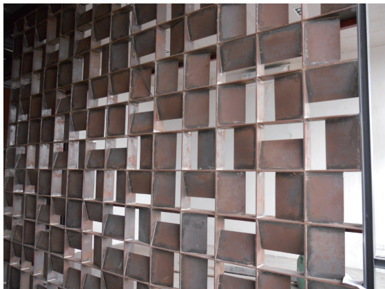
图 2-43 焊接在一起的铁板
