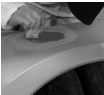
图 1-6 底漆施涂作业
