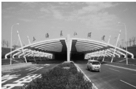
图 1-19 上海长江隧道
