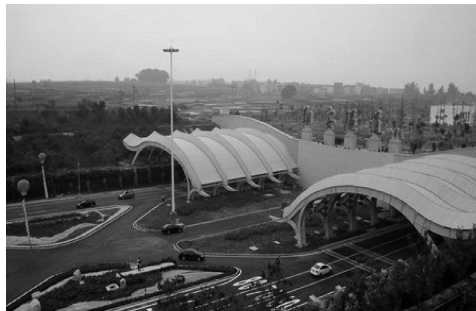
图 1-20 厦门翔安隧道
