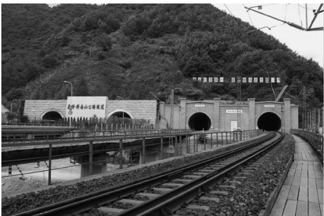
图 1-13 秦岭隧道和终南山隧道
