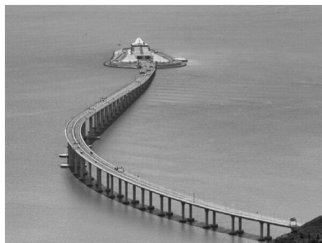
图 1-10 港珠澳大桥海底隧道
