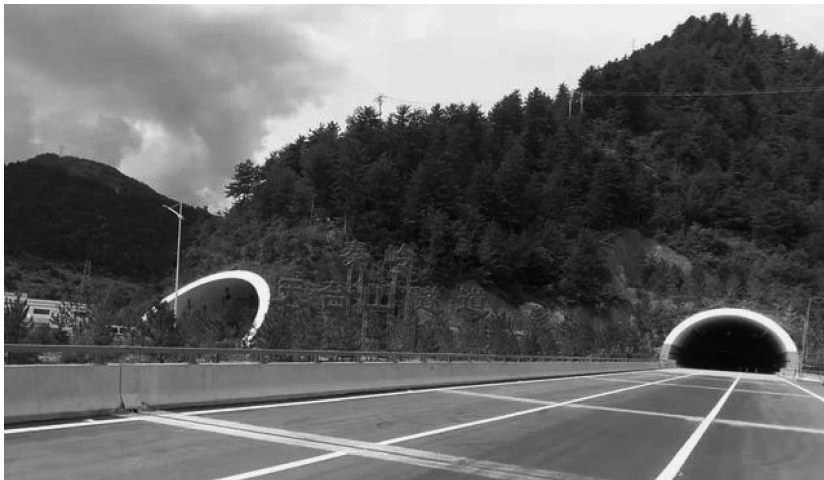
图 1-1 秦岭天台山特长隧道入口
