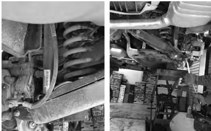
图 1-43 拆下原厂前桥减振器
