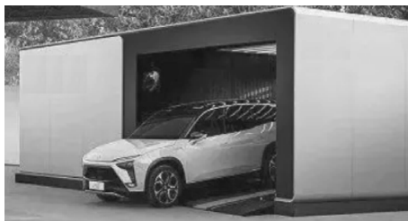
图 1-13 更换电池组充电模式
