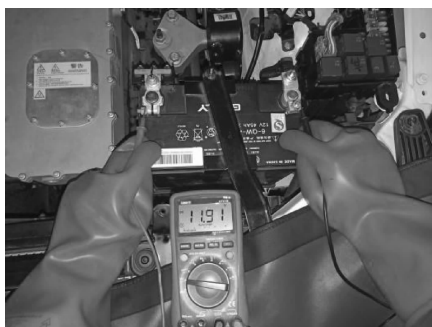
图 1-35 测量低压蓄电池的电压
