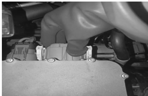
图 1-30 维修开关插头检查
