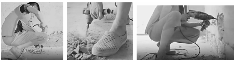
图 1-4 开槽打孔
