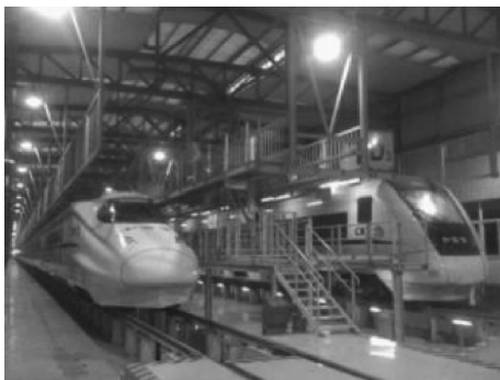
图1-20 双周、双月检库立体检修平台
