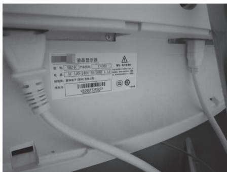
图 1-3-43 安装显示器电源线
