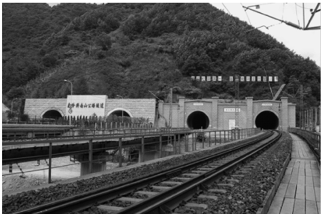
图 1-11 秦岭隧道和终南山隧道
