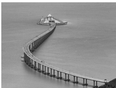
图 1-8 中国港珠澳大桥海底隧道
