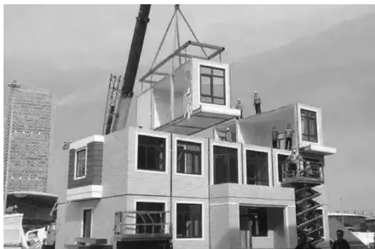
图 0-4 装配式建筑施工现场图
