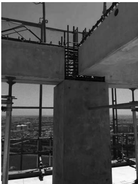
图 1-3 装配式混凝土框架结构体系
