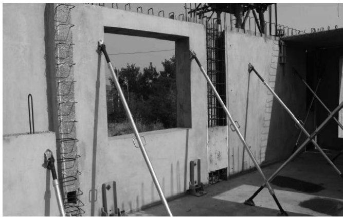
图 1-4 装配式混凝土剪力墙结构体系
