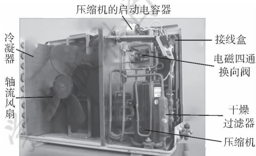
图 1-8 室外机的内部结构
